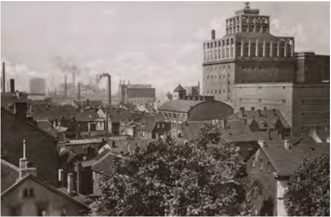
Ende der 1920er-Jahre wurde das Gär- und Lagerhaus der Dortmunder Union-Brauerei erbaut.
