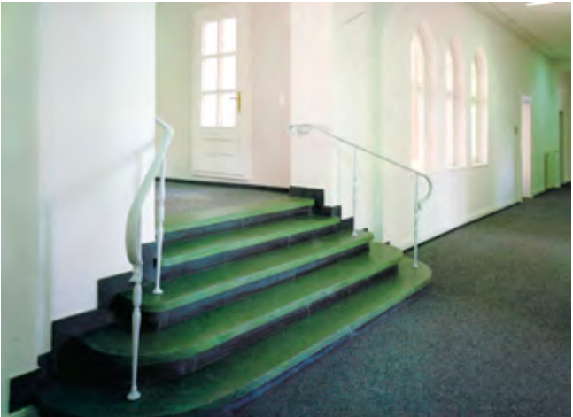
Das Wohlfahrtsgebäude in Eving, in dem sich früher u. a. Kindergarten, Hauswirtschafts- und Kochschule, Wäscherei, Bibliothek und eine Badeanstalt befanden, nach der Restaurierung 1992.
