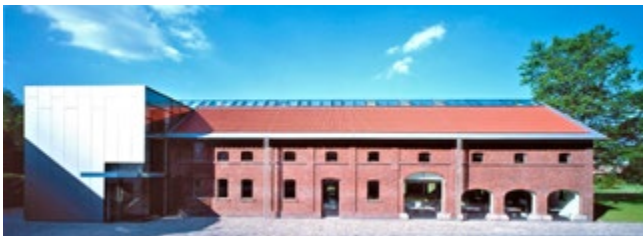
Das Architektur-Atelier in dem ehemaligen Stall- und Scheunengebäude.
