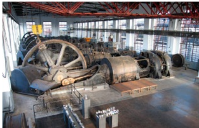
Die 1992 stillgelegte Kokerei Hansa – hier zu sehen die beeindruckende Kompressorenhalle von 1928 – wird seit 2000 denkmalgerecht instandgesetzt.
