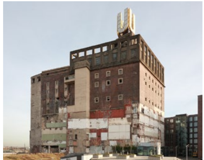
Das Dortmunder U während des Umbaus.
