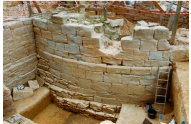
Die ehemalige Stadtbefestigung mit Quadermauerwerk.
