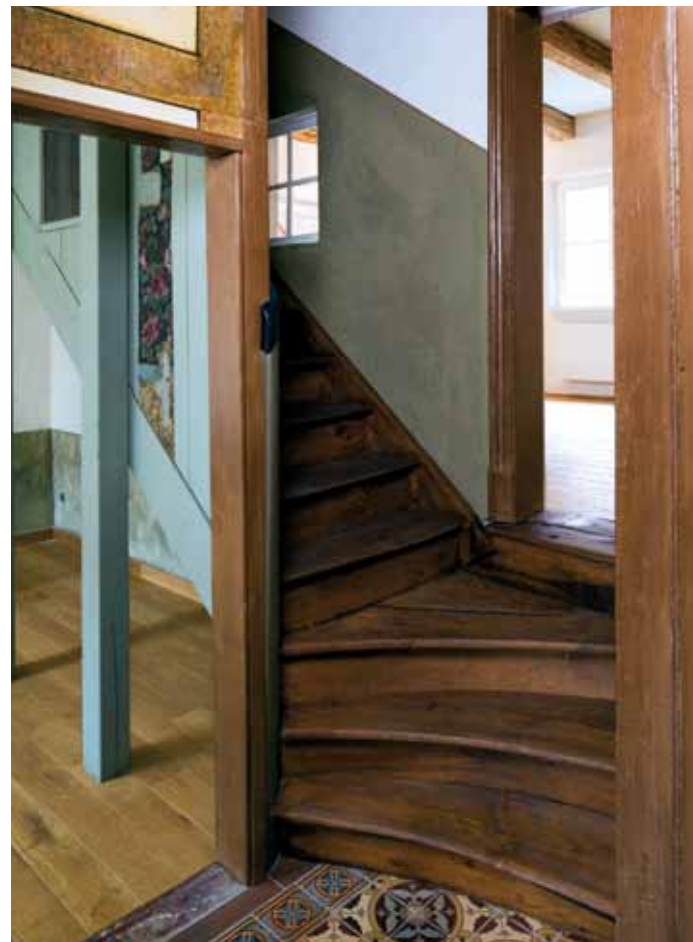
Die originalen historischen Baumaterialien prägen den Charakter des Humberghauses in Hamminkeln-Dingden.
